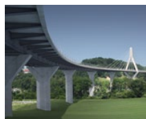
Pont de la Poya (CH)
