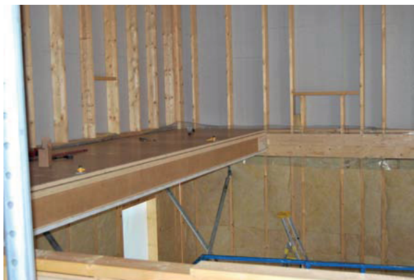
Bjälklag till elevhem, Lindesberg
