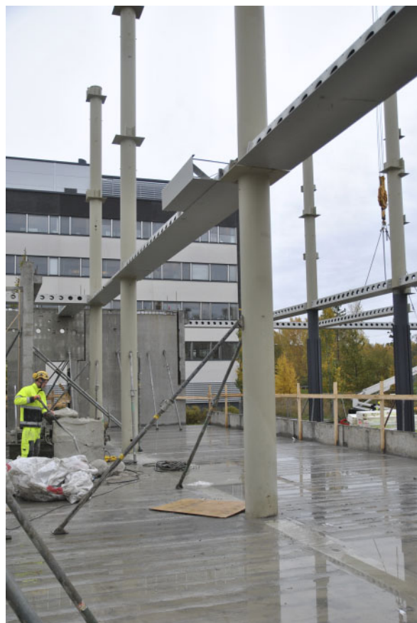
Bild 9. Stagning av en pelare.
