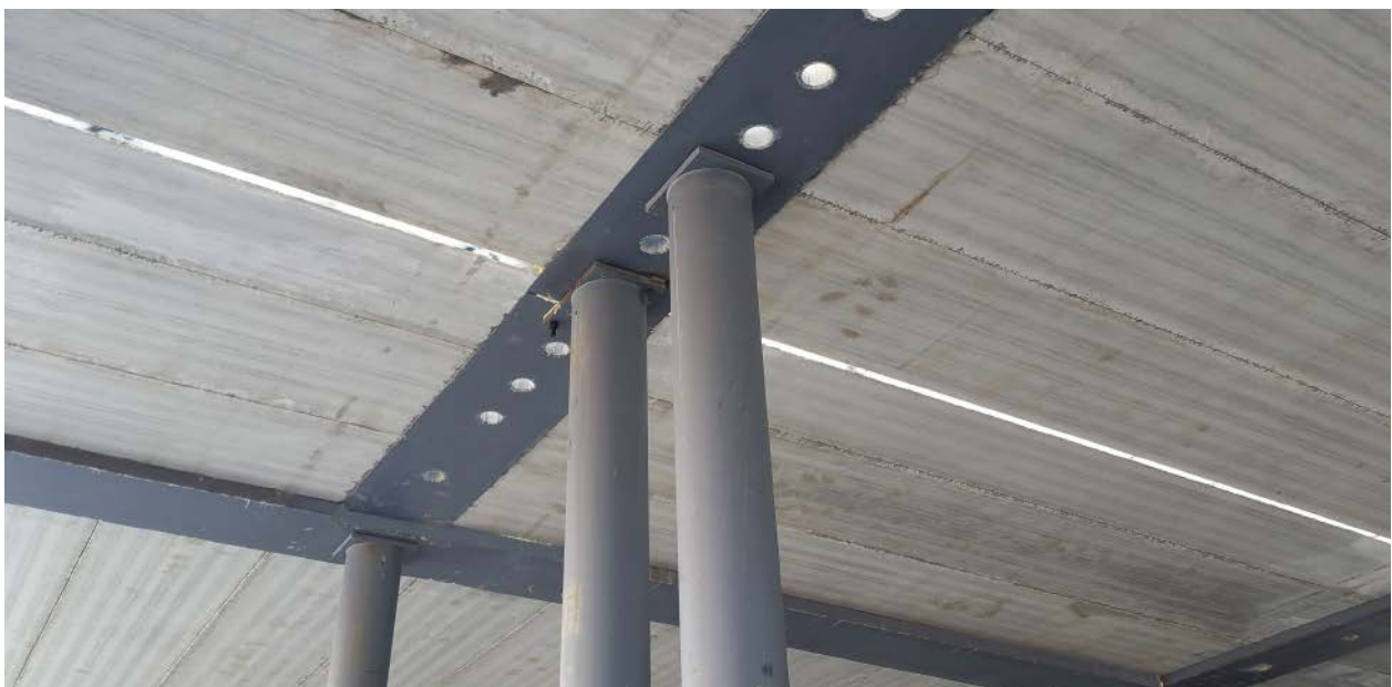
Figur 24. Fabriksinstallerad hylsa för rörgenomföringar.
